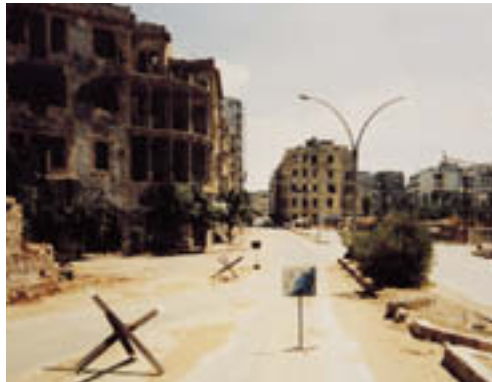
Sodeco passage Photo: as-Sajir
